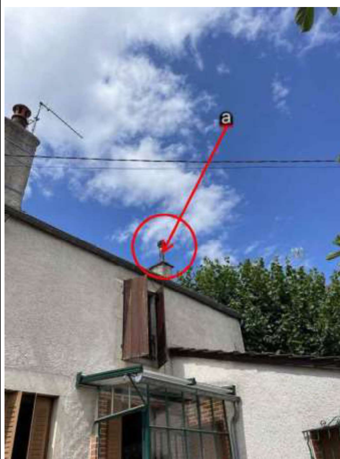
conduit de cheminée en fibre ciment amianté
