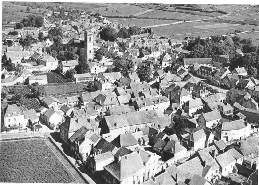
Pommard : vue générale.
