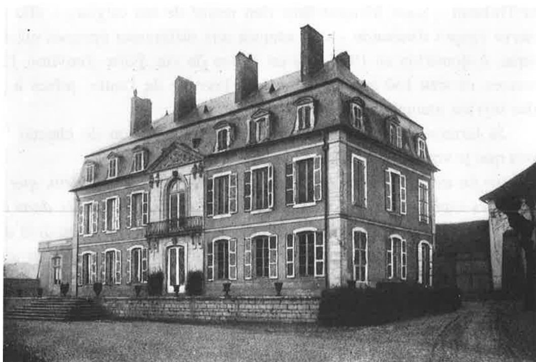
LA FAÇADE POSTÉRIEURE
