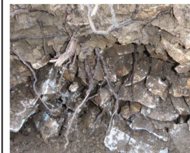
Système racinaire de la vigne parcourant le remblai composé de calcaires variés
